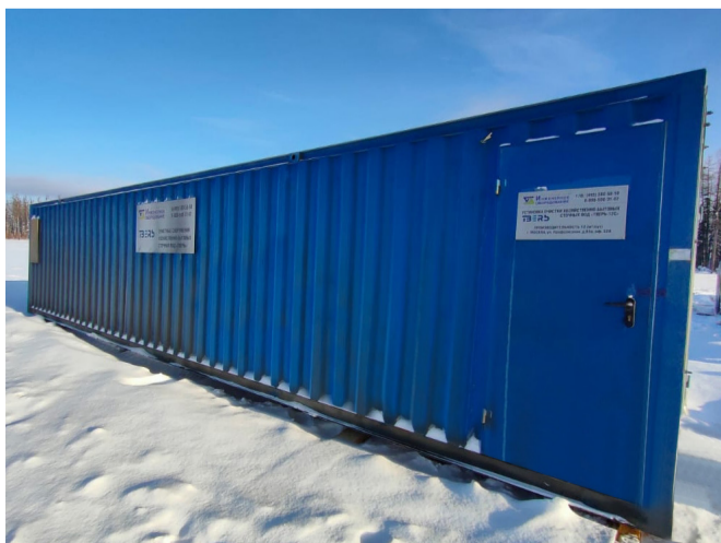
Мобильная станция биологической очистки хозяйственно-бытовых сточных вод ООО «БНГРЭ»
