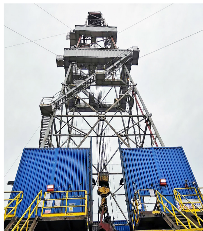
Буровая установка на скважине №92 Юрубчено-Тохомского месторождения
