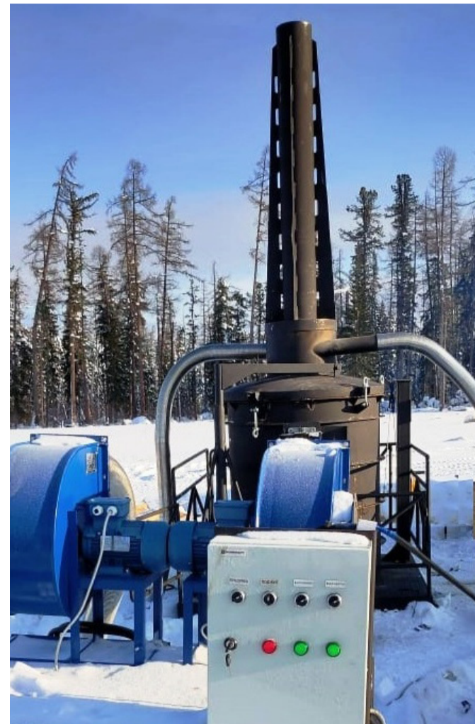
Установка для термической утилизации твердых бытовых и промышленных отходов ООО «БНГРЭ»
